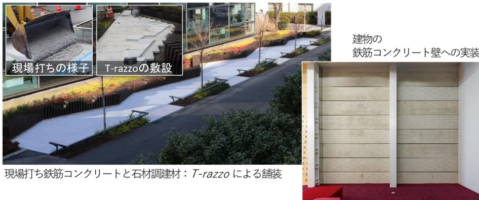
現場打ち鉄筋コンクリートと石材調建材：T-razzoによる舗装
